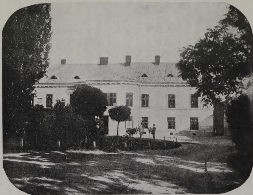
Dworek na Chorążczyźnie (od wejścia).
